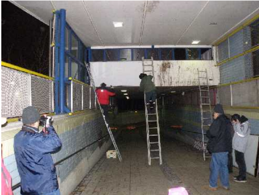
Palkkiin kiinnitetään ensimmäinen peitelevy
