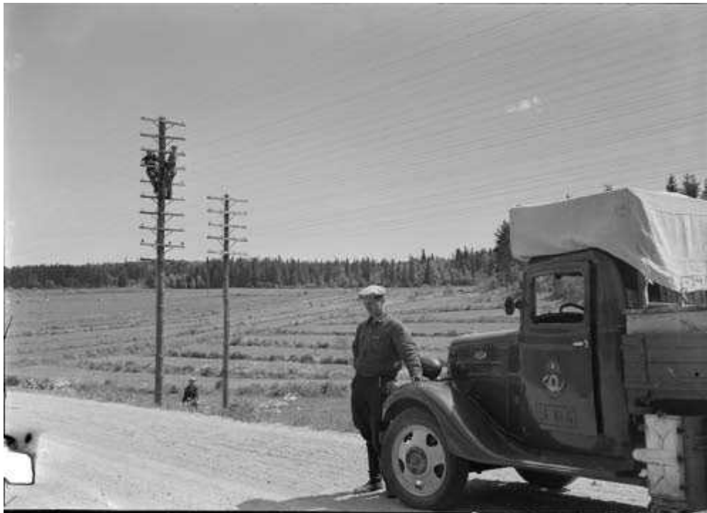
Puhelinjohtojen korjausta Tapanilassa
